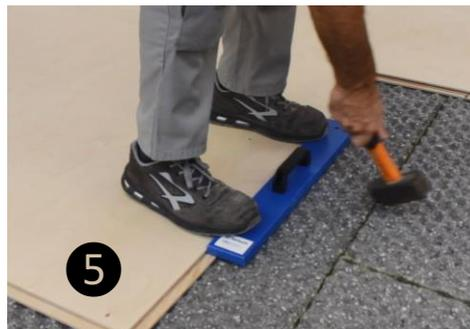
Utilisez un marteau et une cale en nylon pour ajuster le panneau.
