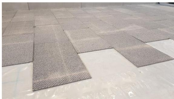
N'oubliez pas de localiser sur la mousse, le centre des réservations, pour permettre de les repérer ultérieurement lors de l'installation des trappons.
