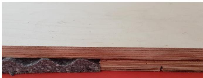
Aux droits des ouvertures de portes, laisser 10cm de large sans mousse ; celle-ci sera remplacée par un contreplaqué de 18mm qui renforcera le passage de porte. Le même processus peut être mis en œuvre pour renforcer les surfaces devant supporter des charges lourdes. Cependant vous ne devez pas oublier que les zones que vous aurez renforcées ne seront pas conformes aux exigences de la Norme EN 14904.
