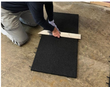
Découpe des dalles à la lame droite ou à la scie sauteuse
