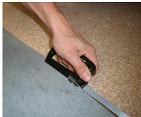
Superposición de 2 a 3 cm (el borde que no se cortó se pone encima del borde cortado previamente con el cortador de bordes). Todos los rollos deben estar correctamente en su lugar antes de comenzar a pegar.
